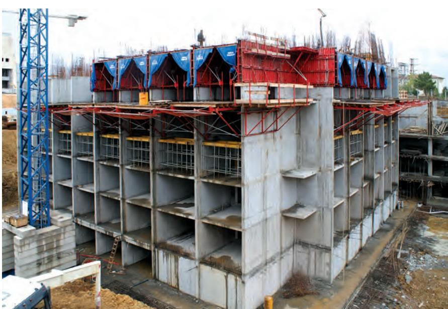
**Yükseltilmiş Alt Saplama Kotu ve Yüksek Aks Betonu :** Yüksek aks betonu, tünel yükseklik ayarını kolaylaştırdığı için, temel betonundaki kot hataları yok edilir. Kontrolsüz dökülmüş aks betonunun, bir üst katta kullanılacak alt saplama kotunu geçmesini öner. Uygulamayı hızlandırır. Kesiti büyütülmüş aks köşebentleri, daha uzun süreli düzgün kullanım sağlar.
