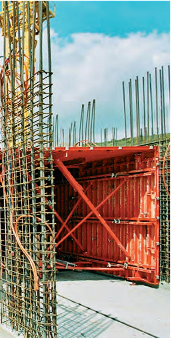
**Modüler Yapı:** ERTF sistemi, modüler yapısı sayesinde bir çok farklı projede kullanılabilmektedir. Standart ölçülerdeki dikey, yatay ve arka panolar farklı kat yükseklikleri ve aks açıklıklarına uyumak için adaptör panolar ile birlikte kullanılır. Bu sayede farklı projelerde sistemi kullanmanın ilave maliyeti minimum seviyede olmaktadır.
