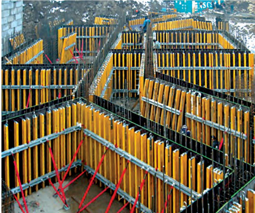
Yüksek perdelerin beton dökümünde de rahatlıkla kullanılabilirler. Pano yüzeyine ahşap veya çelik her türlü tip ve şekilde rezervasyon kolayca monte edilebilir.
