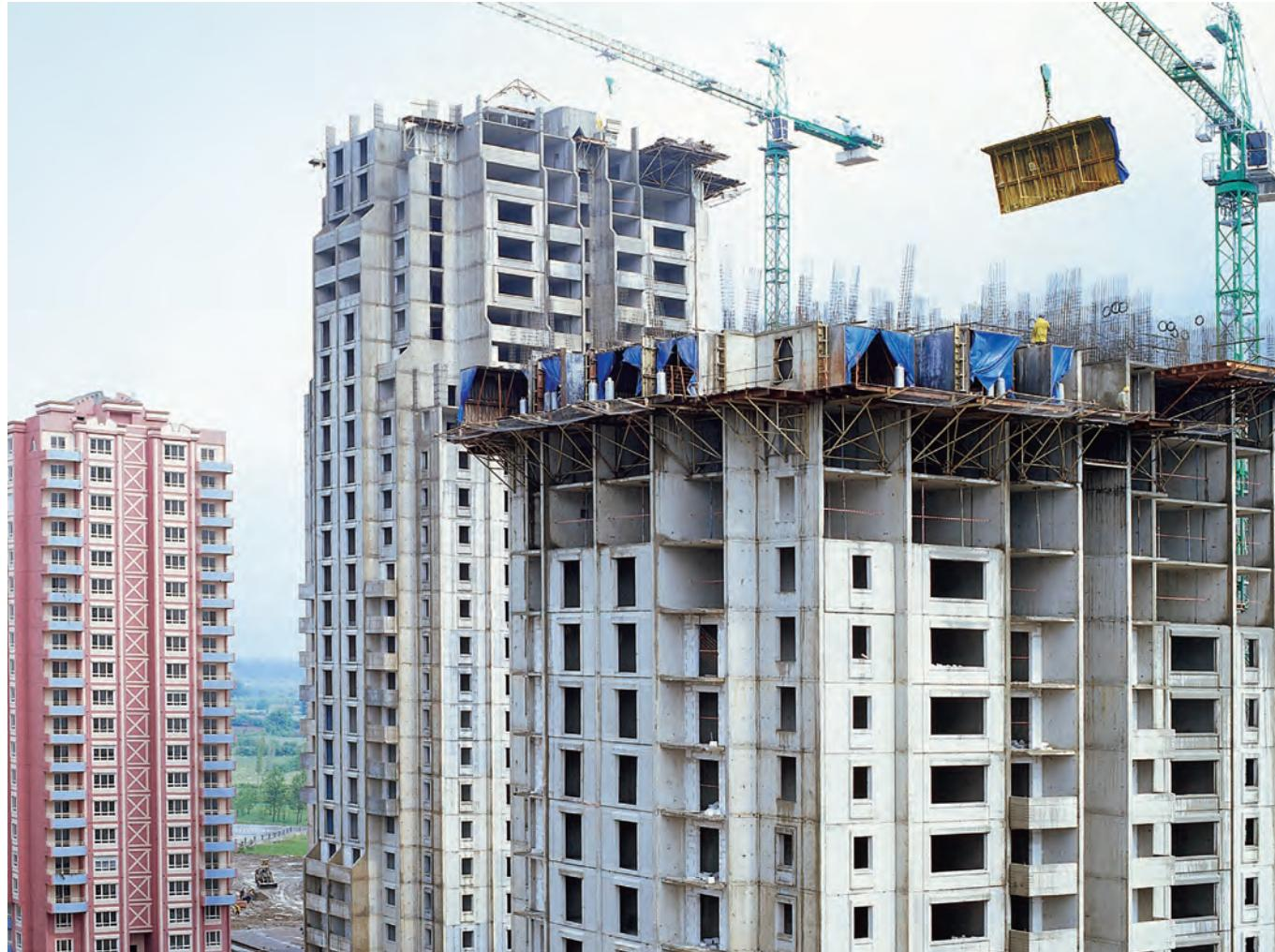
Kalıp sisteminin yüzlerce kez kullanılabiliyor olması kalının birim maliyetini azaltmaktadır.
